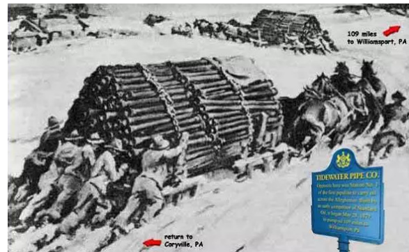
1879 年冬天工人建造潮水管线的情景
