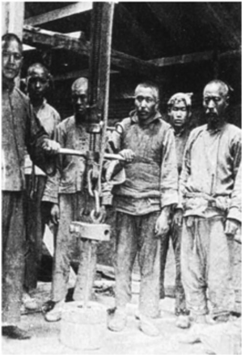
1907年5月延长石油厂新井钻探开工时的场景。
